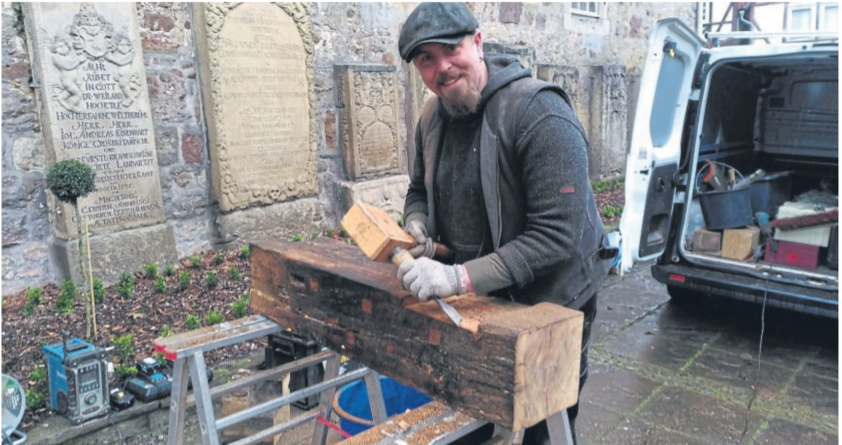
Ersatzholz aus Hann. Münden: Die Holzbaufirma Meyer und Surup aus Bühren repariert das Dach. Hier bereitet Jann Hoffmann einen Balken vor, der beschädigtes Holz ersetzen soll.
