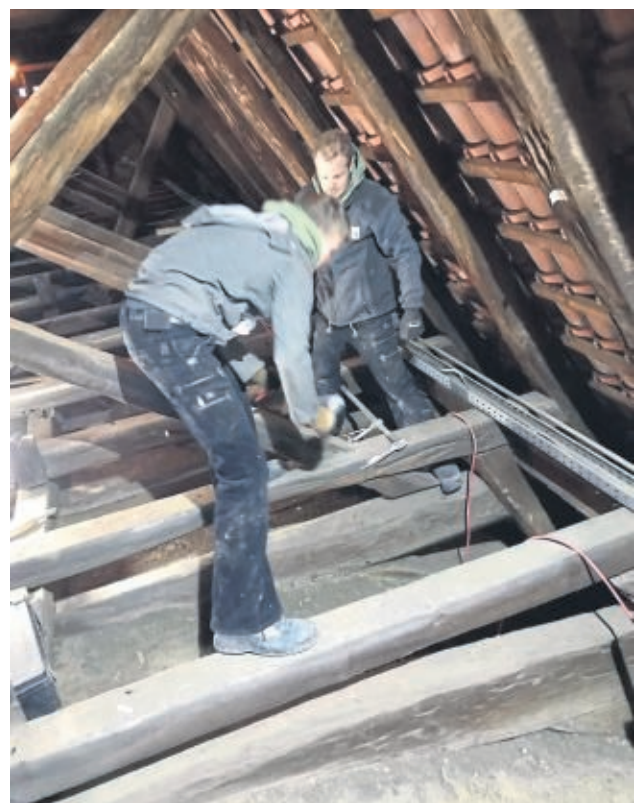
Im Dachstuhl des Kirchenschiffs wurden lose Balken repariert.
